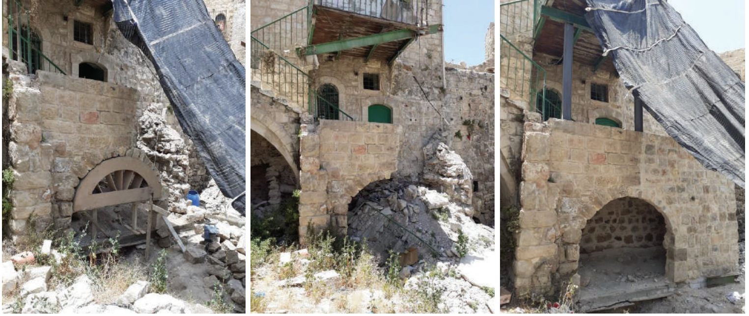
صورة توضح جانب من أعمال المشروع قبل وأثناء وبعد الترميم
