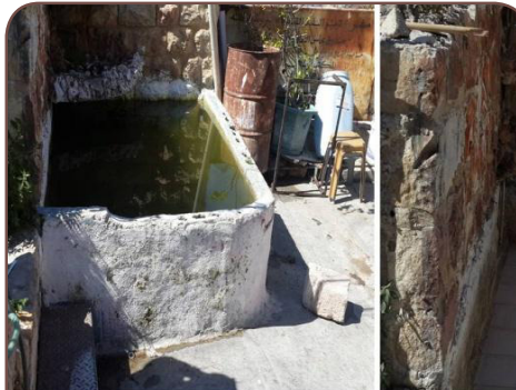
يلاحظ اضافة حوض ماء كبير على اسطح المباني قبل الصيانة
