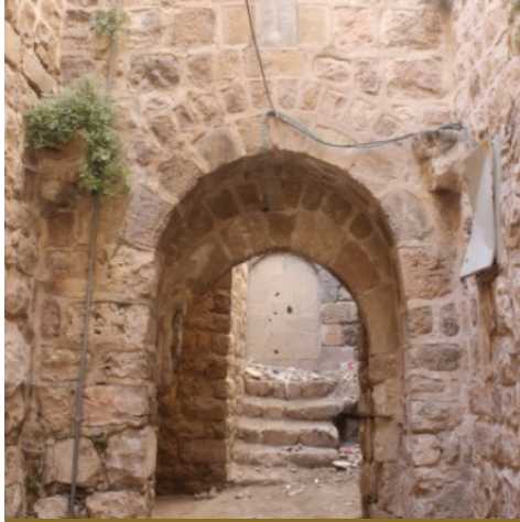
صورة توضح مدخل المبنى
