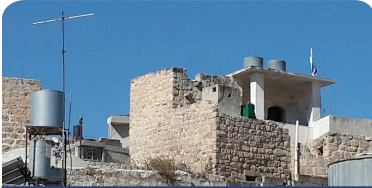
صورة توضح المبنى الأثري الذي يسكنه المواطن يوسف ارفاعية والذي تم اقتحامه من قبل جيش الإحتلال
